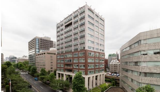
<二松学舎大学九段1号館>
